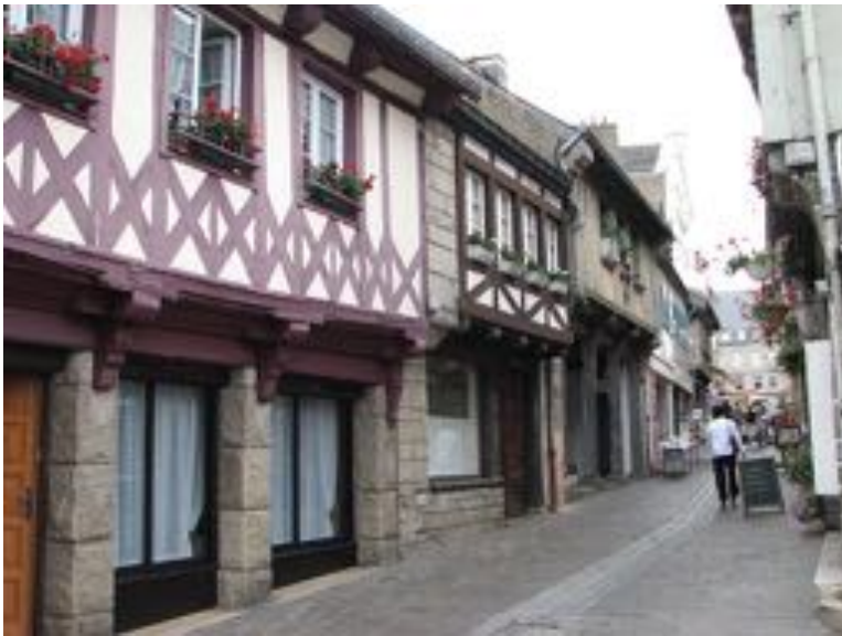
Maisons à colombage rue du Pont
