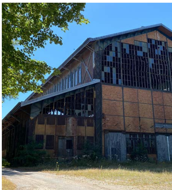
Vue actuelle du Hangar Y, avant les travaux de transformation | © DR
